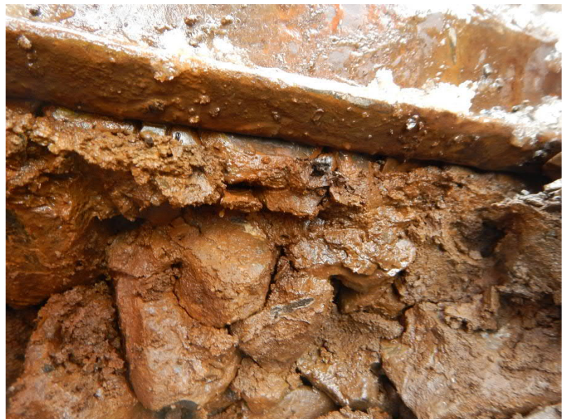
Abb. 3 und 4: fortgeschrittene Einlagerung unterhalb der Schwellen; Porenraum nur noch klein; Schotterbruch und -abrieb lagert sich ein; grosse Kontaktflächen; stark reduzierte Elastizität im Schotterbett; daher hat sich eine Hohlage zwischen UK Schwelle und Schotterbett gebildet (Einsenkung bei Zugsdurchfahrt findet nur noch oberhalb des Schotterbetts statt); Stopfung muss kurzfristig erfolgen
