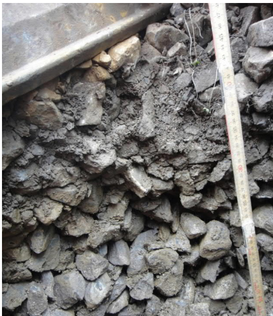
Abb. 3: Reinigbarkeitsklasse S1-2 (wenig bis mittelmässig Betriebsschmutz und Schotterbruch, im Stopfbereich S2-3) über S1. Im Stopfbereich noch ganze Schotterkörner vorhanden und daher noch gerade wirksam stopfbar
