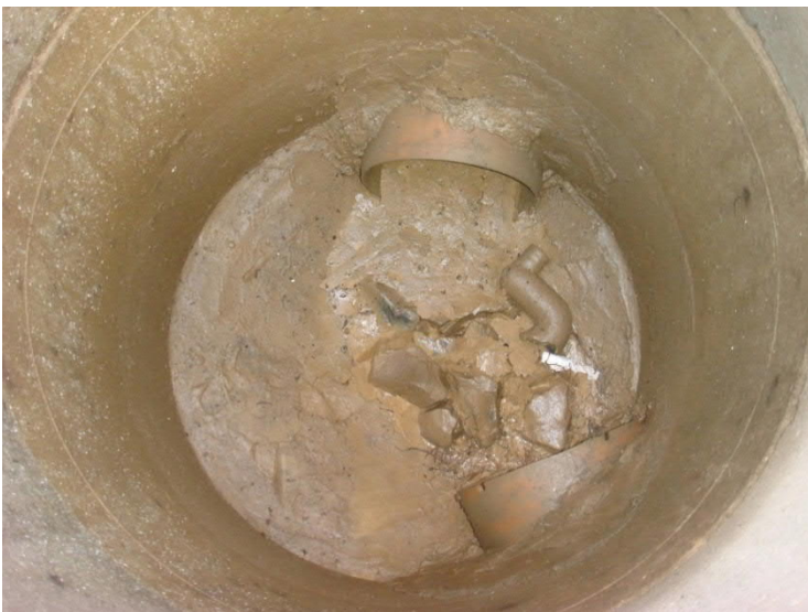
Abb. 14: Blick in Kontrollschacht (hier verschlammt)
