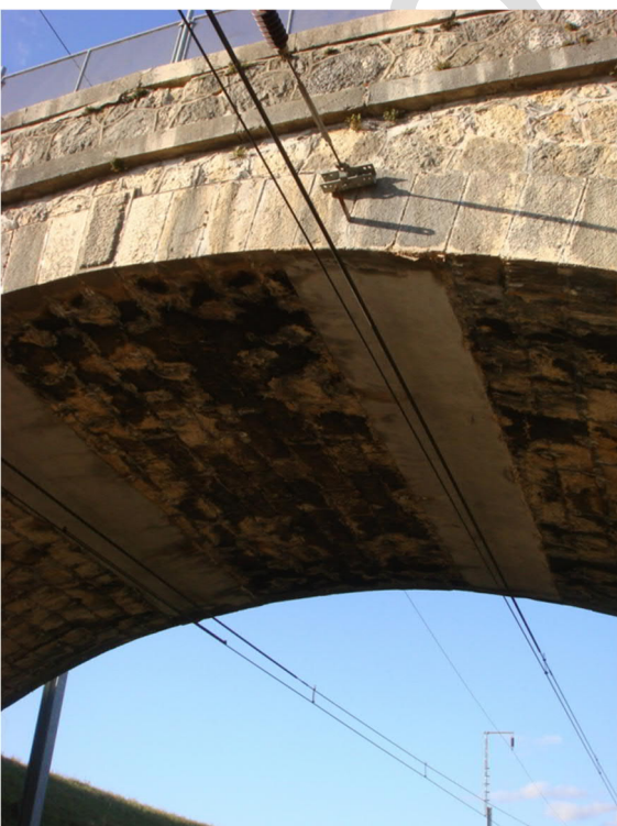
Abb. 16: Evtl. Detail: Befestigung Fahrdrabt bei Überführung (Hinweis für Hebungs möglichkeiten)
