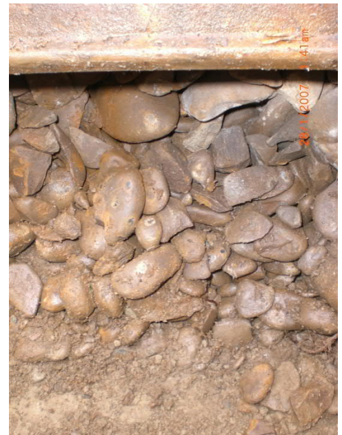
Abb. 3 - 5: Evtl. Detailaufnahmen Schotter: Besonderes wie weisse Stellen / „Schotterfliessen“ (links), Stopfbereich (Mitte) und hoher Anteil Rundkorn (rechts)
