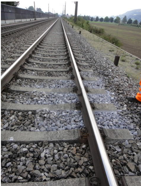
Abb. 3 - 5: Evtl. Detailaufnahmen Schotter: Besonderes wie weisse Stellen / „Schotterfliessen“ (links), Stopfbereich (Mitte) und hoher Anteil Rundkorn (rechts)
