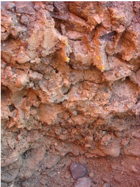
Abb. 5: Reinigbarkeitsklasse S3 (viel Betriebsschmutz und Schotterbruch bzw. -abrieb) ; Porenräume mit kohäsiivem Feinmaterial gefüllt - Verschmutzung von oben bzw. aus dem Schotterbett selbst; nicht mehr wirkungsvoll reinigbar ; Zudem: nur noch einzelne Körner vorhanden
