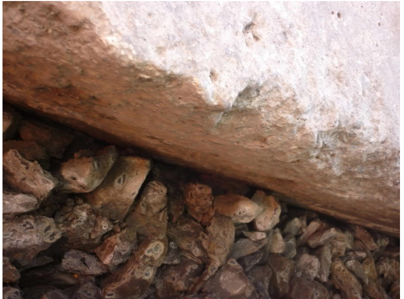
Abb. 6: Blick in den Lastbereich unterhalb der Schwelle bei reduzierter Elastizität des Schotterbetts und bereits vorhandener Hohllage UK Schwelle und Schotter: weniger Betriebsschmutz und Schotterbruch; eben nicht relevanter Bereich für Beurteilung der Notwendigkeit von Stopfungen und der Stopfbarkeit
