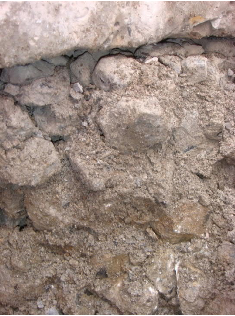
Abb. 5: nebst fortgeschrittener Einlagerung und Hohl-lagenbildung sind Schotterkörner im Stopfbereich vermehrt zerbrochen; Stopfung muss kurzfristig erfolgen ist aber nur noch bedingt wirksam (noch Körner vorhanden)
