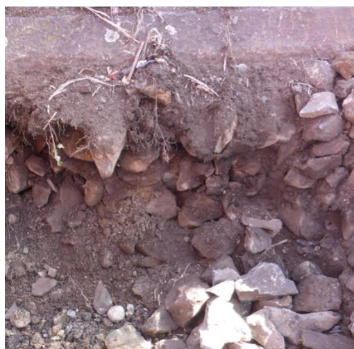
Abb. 4: Reinigbarkeitsklasse S2 (mittelmässig bis viel Betriebsschmutz und mittelmässig Schotterbruch) ; v. a. oben eingewachsene Pflanzen sichtbar Zudem: Korngrössenverteilung genügend, einige Rundkörner, ansonsten kantengerundet; Reinigung möglich, aber nur sinnvoll, wenn vorliegendes Gleis ausreichende Nutzungsdauer erreicht hat und künftig ähnliche Belastung erfährt
