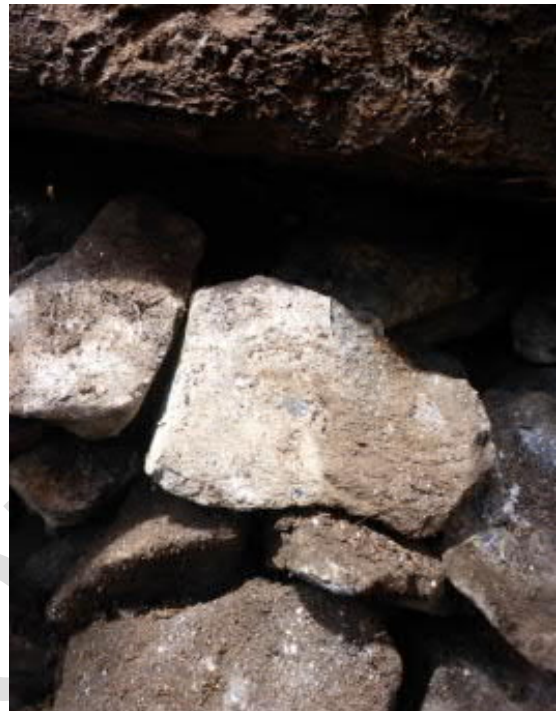
Abb. 2: beginnende Einlagerung unterhalb der Schwellen; Porenraum nimmt ab; Kontaktflächen werden grösser; Elastizität im Schotterbett ist reduziert; Stopfung muss mittelfristig Einlagerung stören
