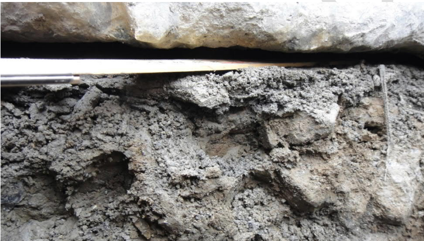
Abb. 7: stark reduzierte Elastizität des Schotterbetts und bereits vorhandener Hohllage UK Schwelle und Schotter: viel Schotterbruch und –abrieb; nicht mehr wirksam stopfbar
