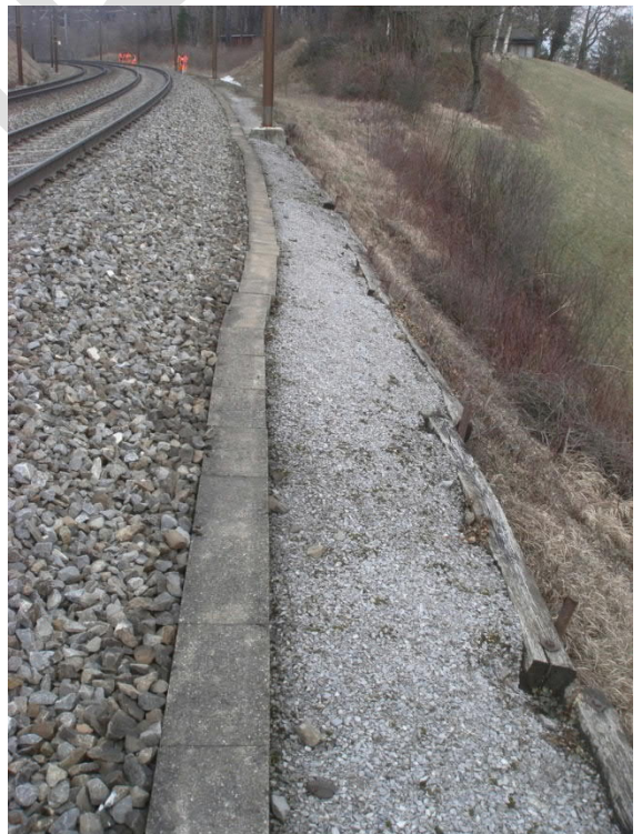
Abb. 15: Evtl. Detail: Abrutschender Kabelkanal / abrutschende Bankethalterung
